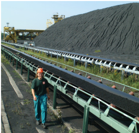
Dopravník uhlí v elektrárně Dětmarovice
