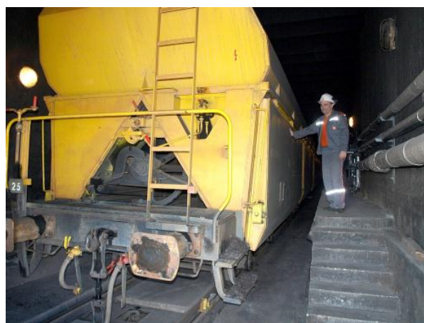
Kontrola teploty vozů s uhlím v rozmrazovacím tunelu v Elektrárně Počerady.
