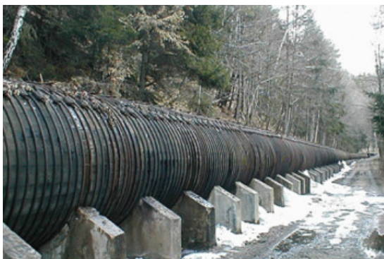
Dřevěné potrubí u Sečské přehrady
