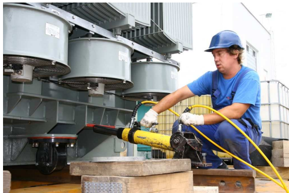
Při usazování transformátoru musela pomoci hydraulika.
