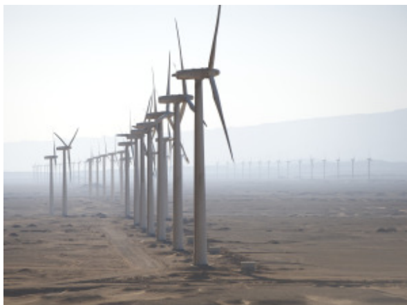
Ve větrném parku Zafarana u Hurghady se „točí“ přes 480 „větrníků“ s celkovou kapacitou 360 MW e
