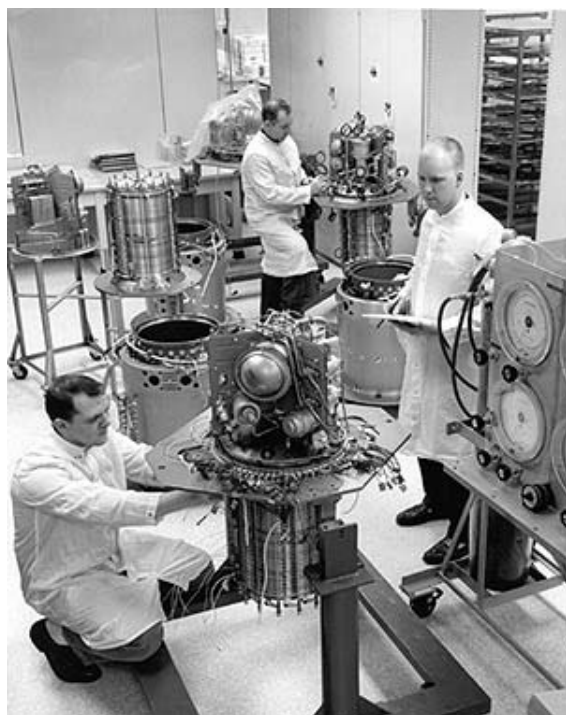
Obr. 6-1 Technici v Pratt & Whitney montují palivové články pro modul Apollo, 1964
