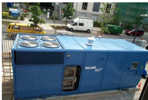
Obr. 6-12 250kW PEM jednotka - Bewag, Německo [56]
