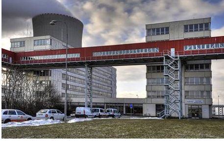
33. Úkryt č. 3 – provozní budova šatny
