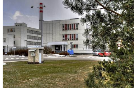
34. Úkryt č. 4 – školicí středisko
