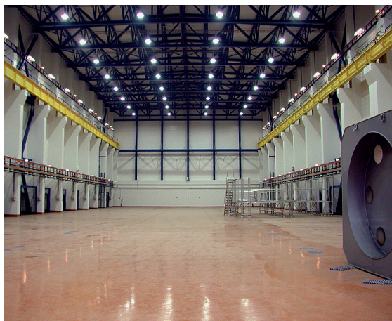
▣ Mezisklad použitého paliva v jaderné elektrárně Dukovany
