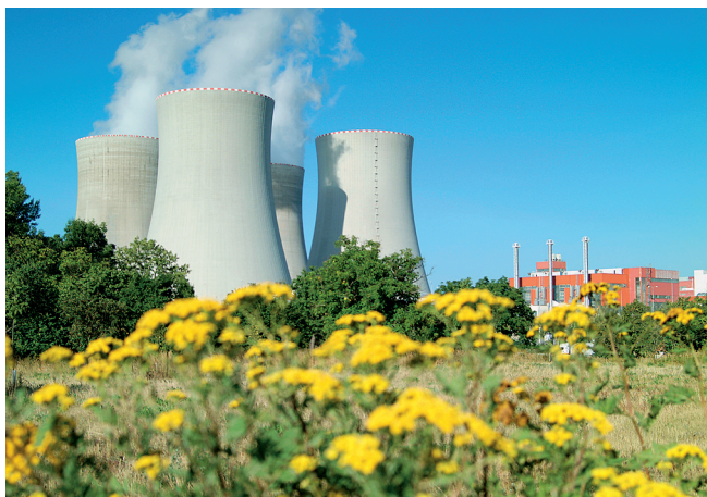
■ Současná podoba elektrárny
