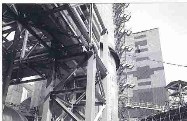
Elektrárna Prunéřov I
