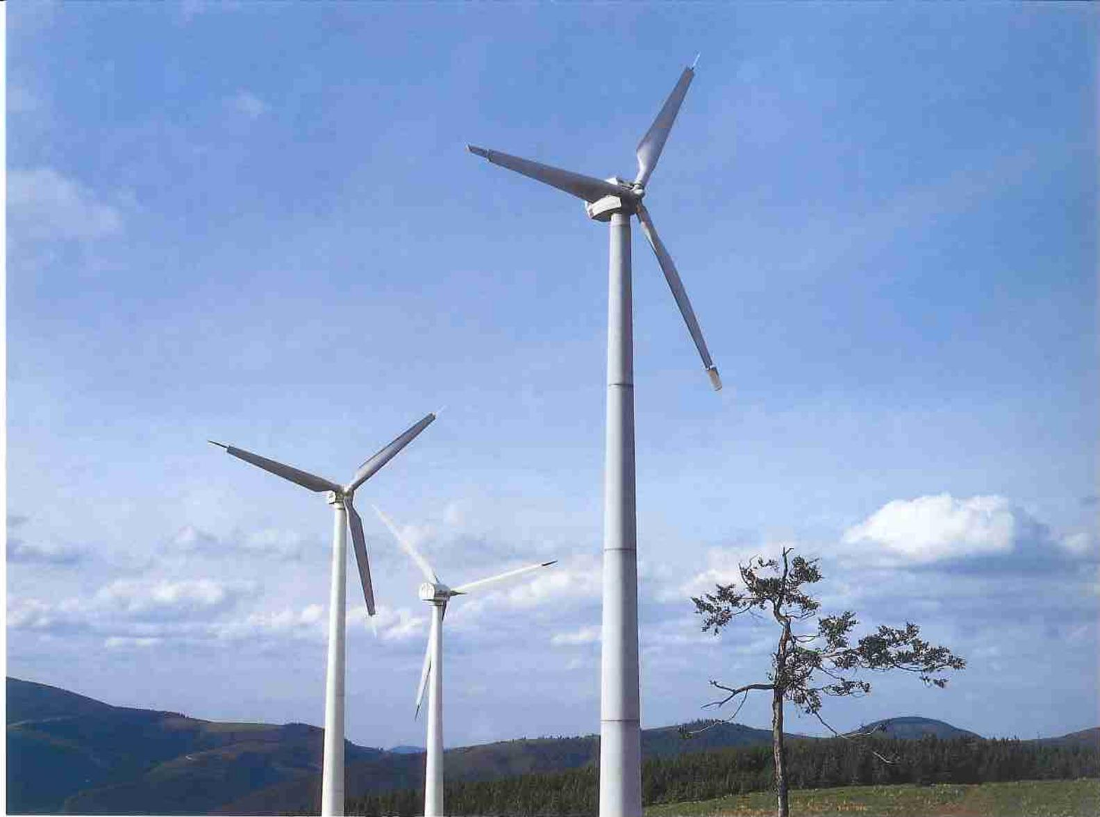
*K první demonstrační větrné elektrárně ČEZ, a. s., v lokalitě Dlouhá Louka u Oseka v Krušných horách brzy přibude další demonstrační větrná farma tří elektráren o výkonech 220 kW, 315 kW a 630 kW. Výsledky zkoušek a měření budou určeny zájemcům o výstavbu těchto alternativních zdrojů elektřiny.*
