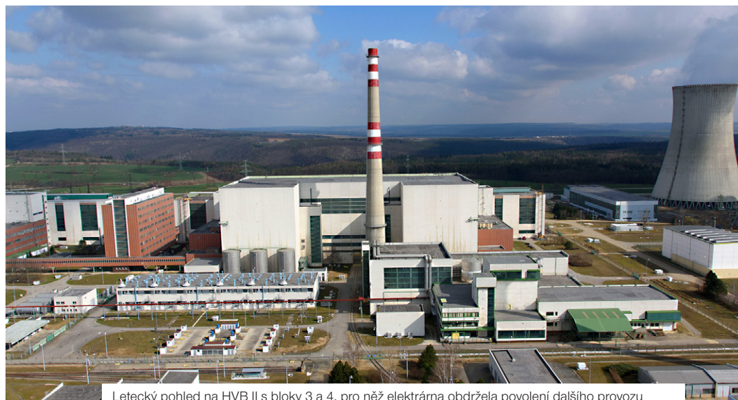
Letecký pohled na HVB II s bloky 3 a 4, pro něž elektrárna obdržela povolení dalšího provozu
