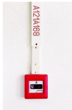
Vnitřní tlačítkový hlásič požáru
