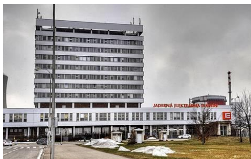
Úkryt č. 1 – administrativní budova
