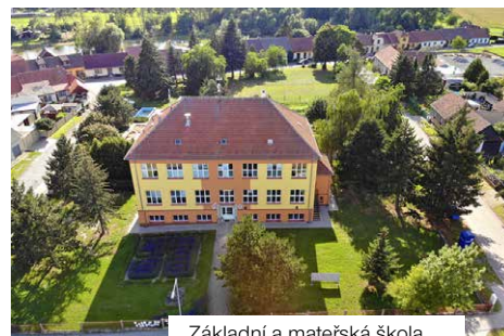
Základní a mateřská škola
