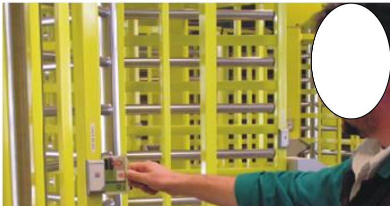
Způsob načítání karty do čtecího zařízení turniketu (přiložit bokem, pohled na zelené světlo)
