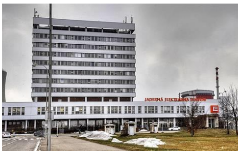
Úkryt č. 1 – administrativní budova
