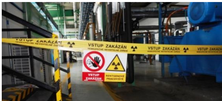
Ohraničení a označení přechodného pracoviště
