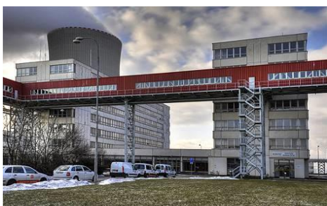
Úkryt č. 3 – provozní budova šatny
