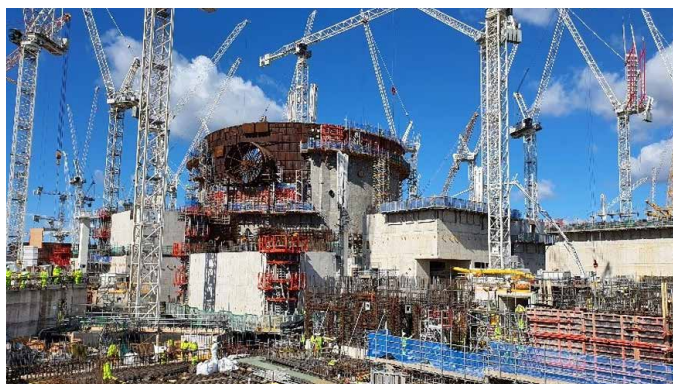
Blok EPR ve výstavbě na JE Hinkley Point C
