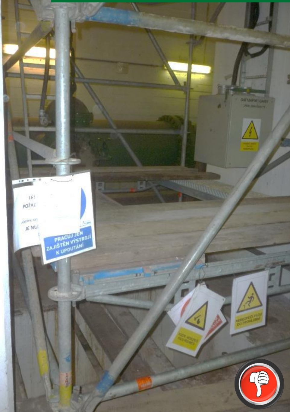
Otvor 1x1 m uprostřed podlahy
