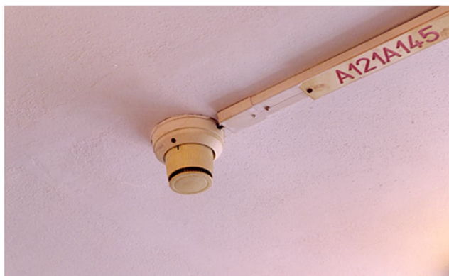
Obrázek 7.5: Elektrická požární signalizace (EPS)
