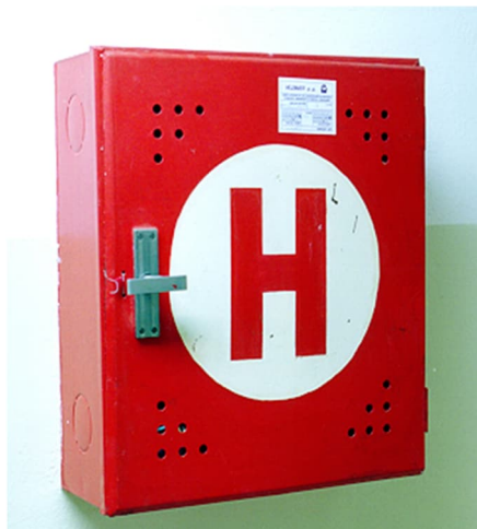
Obrázek 7.3: Požární hydrant
