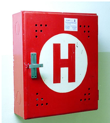
Obrázek 7.3: Požární hydrant
