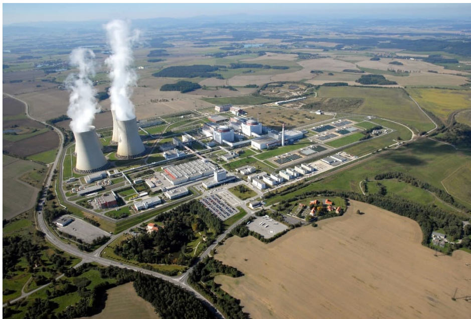
Obrázek 2.4: Jaderná elektrárna Temelín
