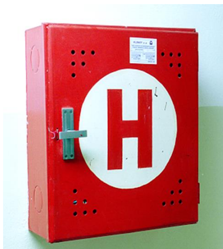
Obrázek 7.3: Požární hydrant
