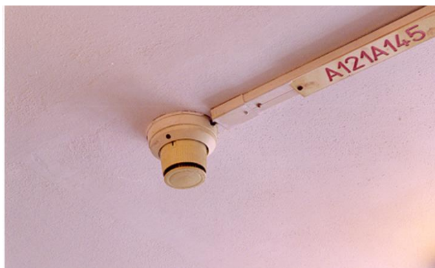
Obrázek 7.5: Elektrická požární signalizace (EPS)
