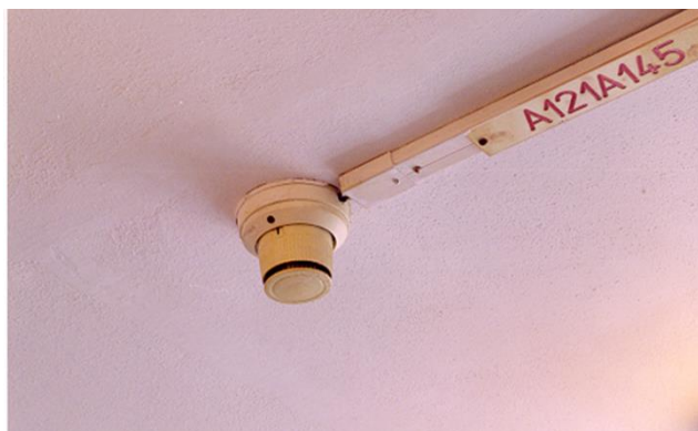
Obrázek 7.5: Elektrická požární signalizace (EPS)
