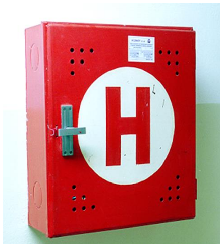
Obrázek 7.3: Požární hydrant
