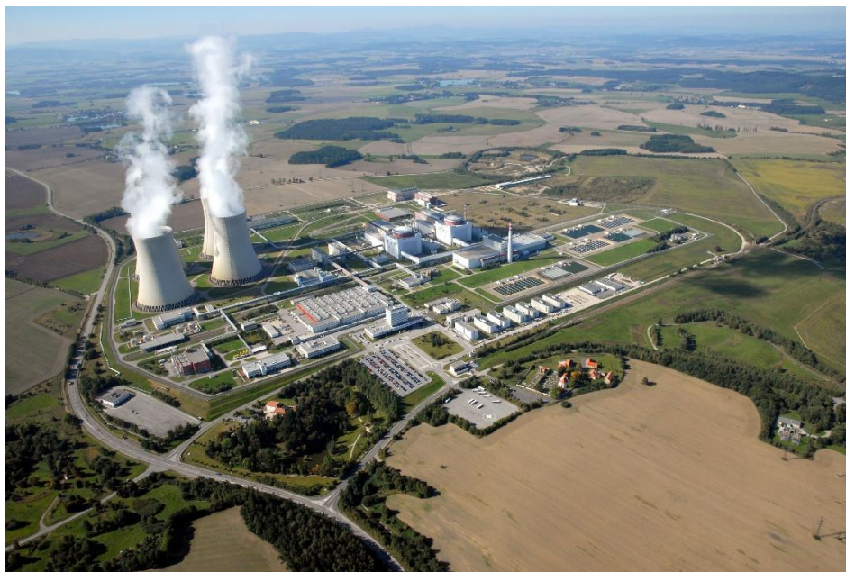
Obrázek 2.4: Jaderná elektrárna Temelín
