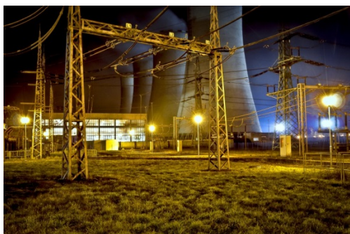
Rekonstrukce osvětlení – Elektrárna Dětmorovice
