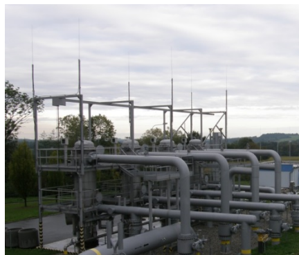
Ochrana před bleskem a přepětím PZP Třanovice
