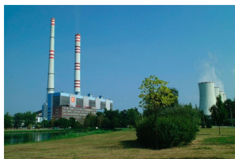
Elektrárna Dětmarovice, a. s.
