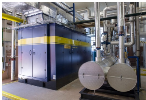
Stavba kogenerační jednotky
