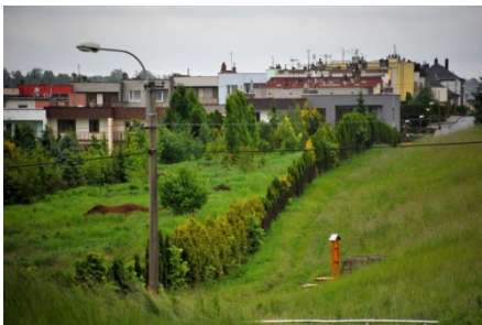
Rekonstrukce veřejného osvětlení - obec Bolatice
