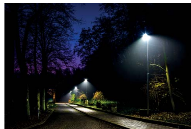
Veřejné osvětlení – Landek-Slezská Ostrava
