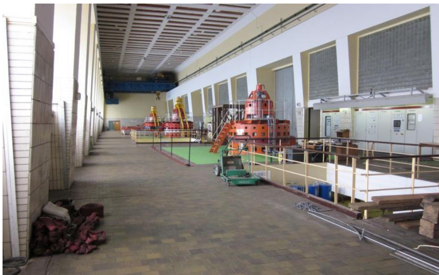
Jeřábová dráha - strojovna
