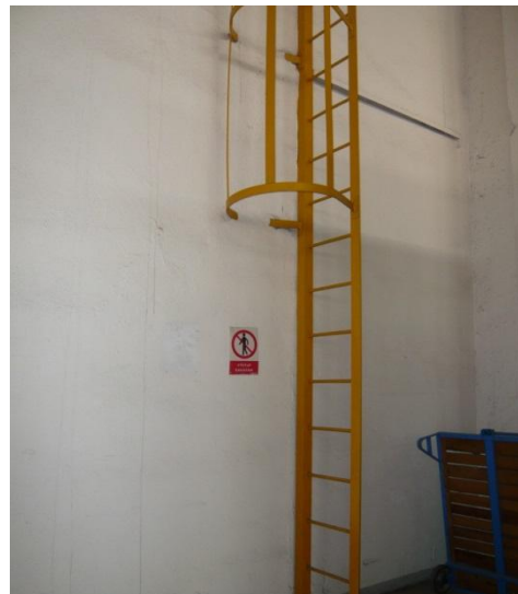
Přístup na jeřábovou dráhu
