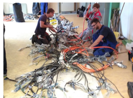
Kabelové svazky po demontáži původního zařízení
