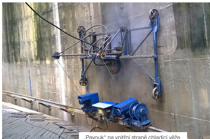
„Pavouk“ na vnitřní straně chladicí věže
