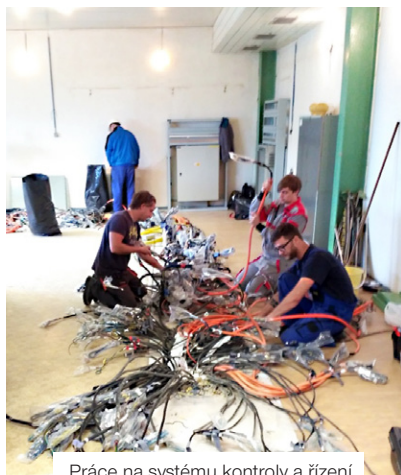
Práce na systému kontroly a řízení
