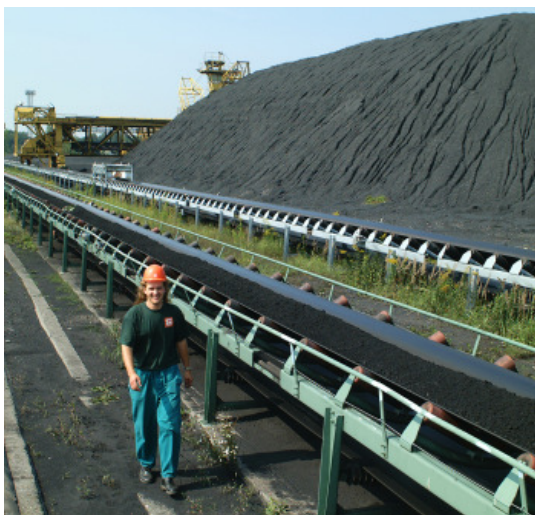
Dopravník uhlí v elektrárně Dětmárovice
