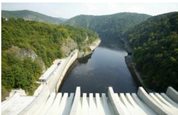
Vodní elektrárna Slapy
