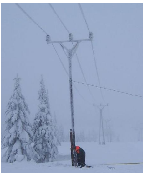
Energetik opravuje opěrný bod poškozený sněhovou kalamitou
