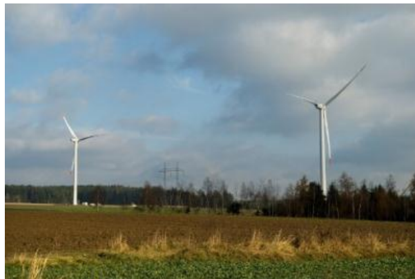
Větrná elektrárna Věžnice
