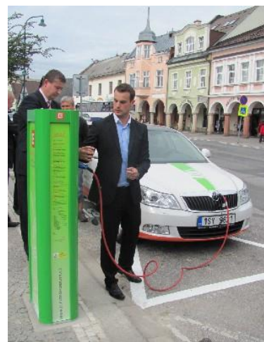
Dobíjecí stanice ve Vrchlabí
