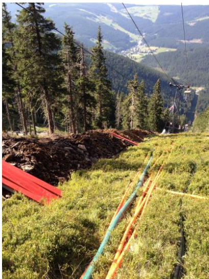
Pokládka kabelů v náročném horském terénu
