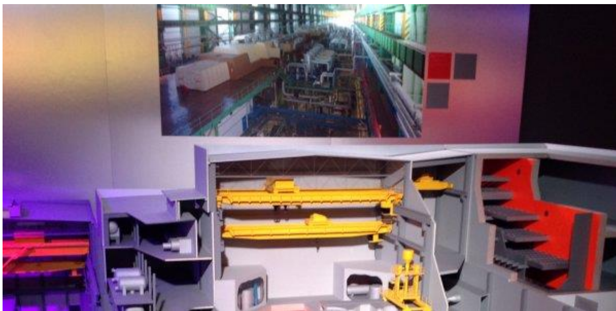
Model výrobního bloku Jaderné elektrárny Dukovany znázorňuje všechny okruhy chladicí vody, palivové a elektrické systémy a pomocné provozy.
