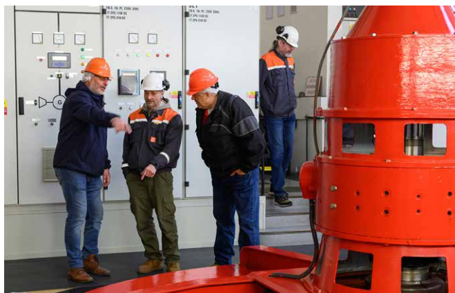
V elektrárně Kníničky
