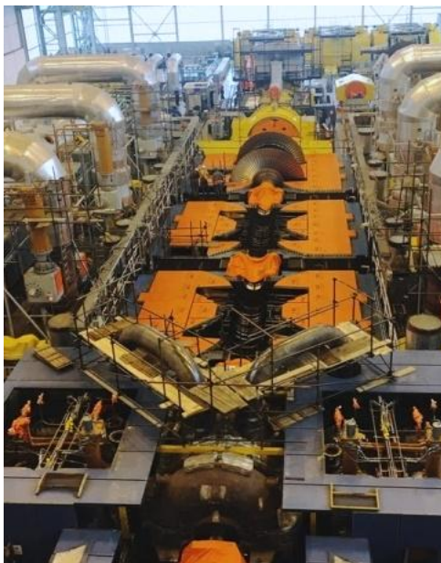
Obrázek 15.1: Otevřená technologie opatřená prostředky FME
