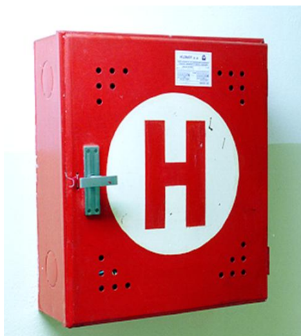
Obrázek 7.3: Požární hydrant
