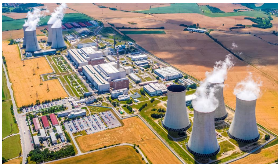
Obrázek 2.1: Jaderná elektrárna Dukovany
